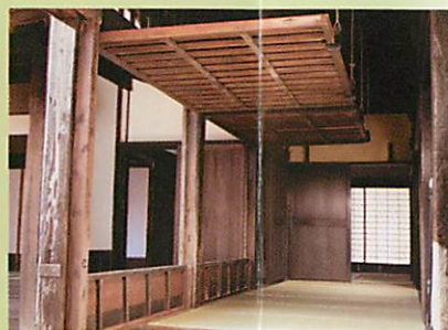
「広間」の南面にあり、四季折々の採光や通風に適した工夫が凝らされている。
