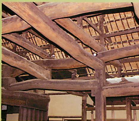
小屋梁 土間の天井部は豪壮な梁の架構が見事である。
